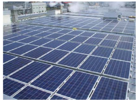
設置パネルの状況
