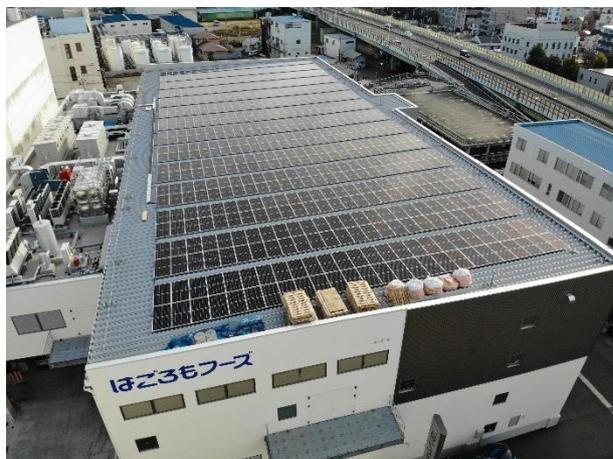
新清水プラントに設置した太陽光発電システムの出力規模は204.95kWで、年間発電量は、292,426kWh(基準年間供給電力量)です。今後は、同プラントの消費電力の約15%が太陽光から供給される自然エネルギーの電力に置き換わり、年間で約124トン、20年間では約2,500トンのCO<sub>2</sub>(二酸化炭素)を削減することができます。
